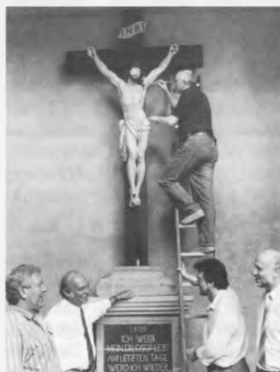
Freude über das gelungene Werk beim Abschluß der Restaurierungsarbeiten am Portikus auf dem Ehrenfriedhof an der Werdener Straße (v.l.n.r.): Jonges-Schatzmeister und Bauleiter Klaus Ipach, Baas Heinz Beyer, Stadtkonservator Hans-Uwe Balzar und Stadtdirektor Dr. Horst Blechschmidt.
